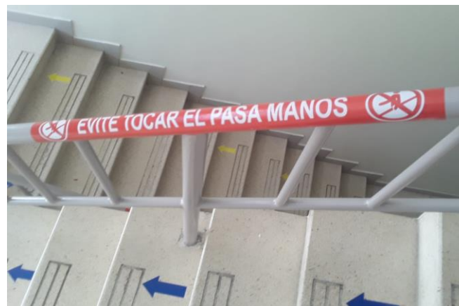
Señalización de prohibiciones en los pasos manos
