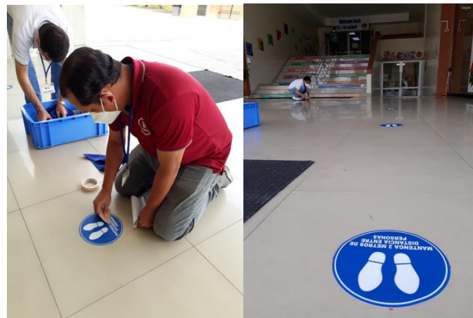
Instalación de señalizaciones del distanciamiento
